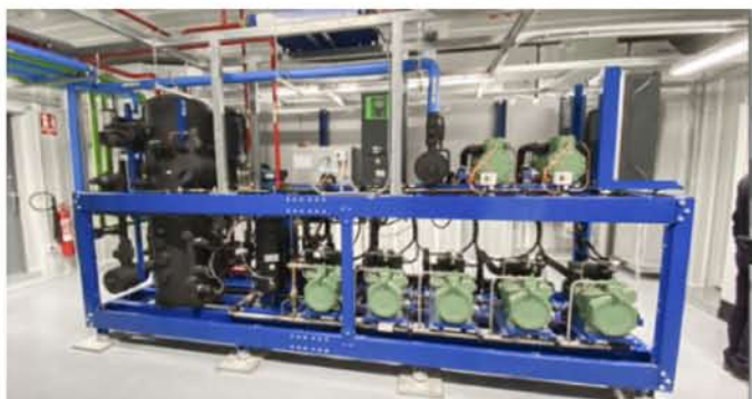
L'impianto di Consum di Benecassim.
