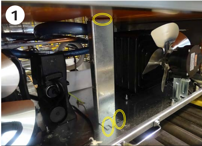
Schrauben Sie die 3 Befestigungsschrauben los
